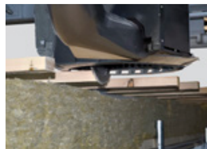
Squadratura dei listelli del tetto
